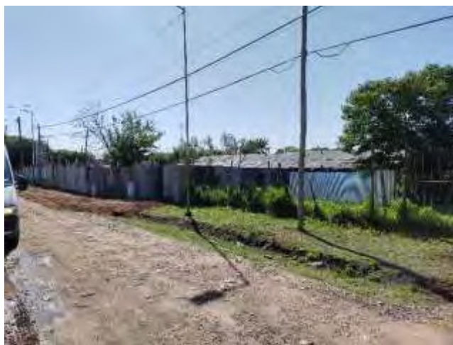
Figura 35: Darragueira esquina Gral. Pico. Predio Estación de Bombeo Cloacal
