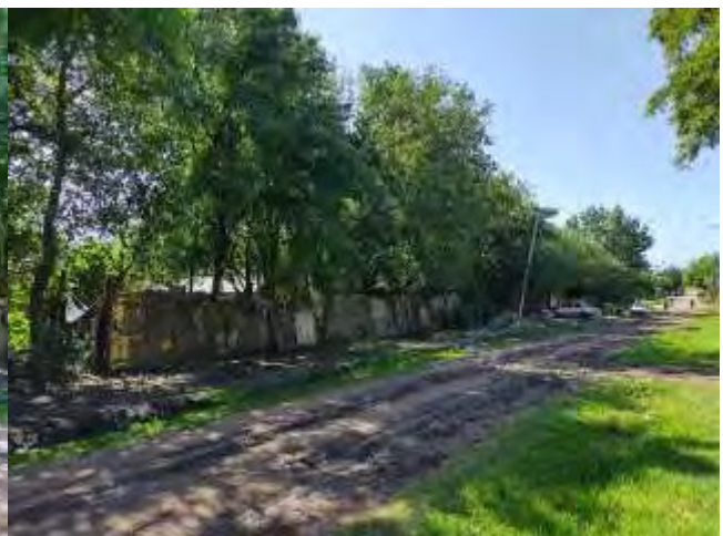
Figura 38: Gral. Pico esquina Darragueira. Predio Estación de Bombeo Cloacal
