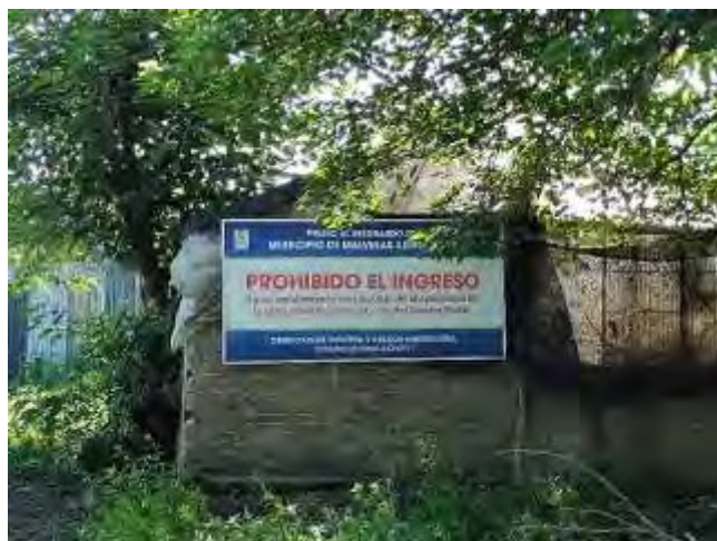
Figura 39: Gral. Pico esquina Darragueira. Predio Estación de Bombeo Cloacal
