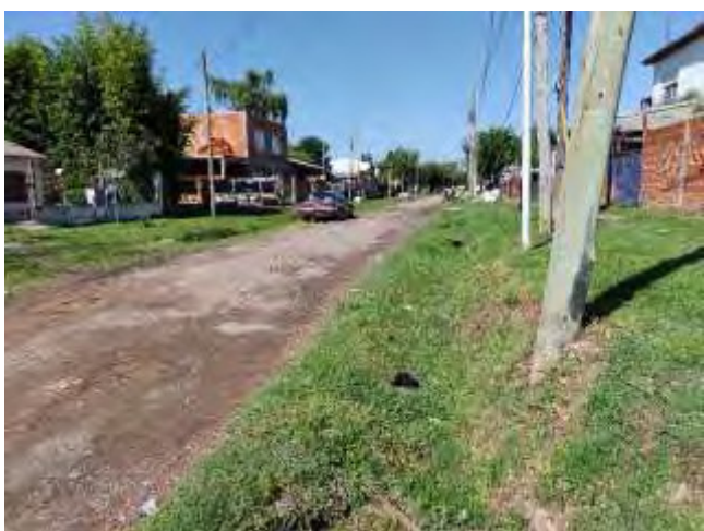
Figura 29: Darragueira esquina Villafañe hacia Juan de Herrera
